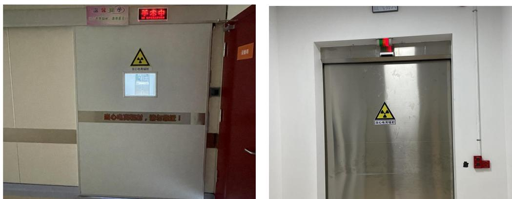
图 7-1 DSA 和医用电子直线加速器机房警示标志、工作状态指示灯
