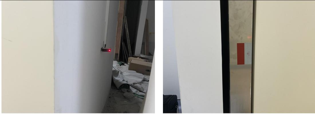
图 7-3 加速器机房防护门防挤压装置
