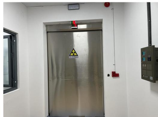
图 3-14 加速器机房防护门（加速器机房南侧）
