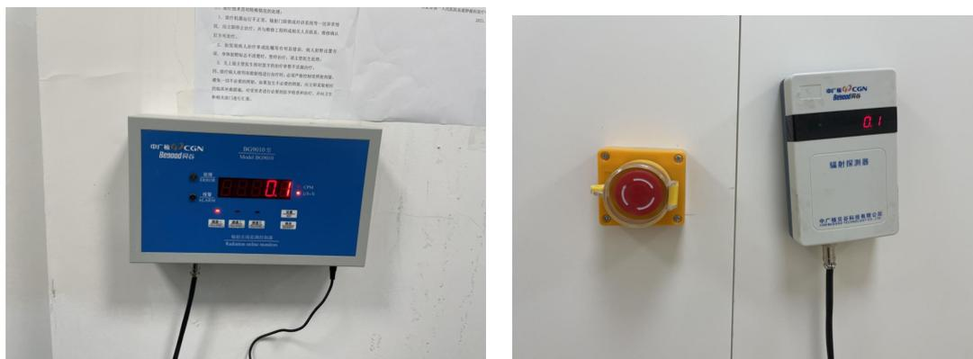
图 7-9 医用电子直线加速器机房辐射探测器
