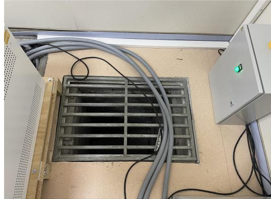
图 3-17 医用电子直线加速器机房排风及进风口
