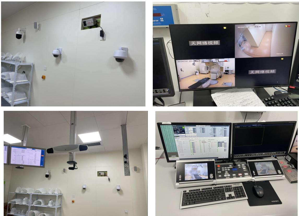
图 7-4 医用电子直线加速器机房监控系统
