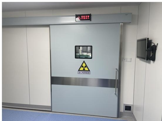
图 7-1 复合手术室机房警示标志、工作状态指示灯
